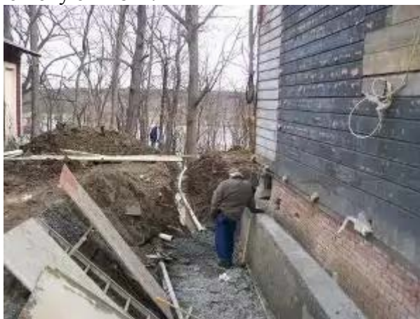
Усиление фундамента ленточного железобетонной обоймой
