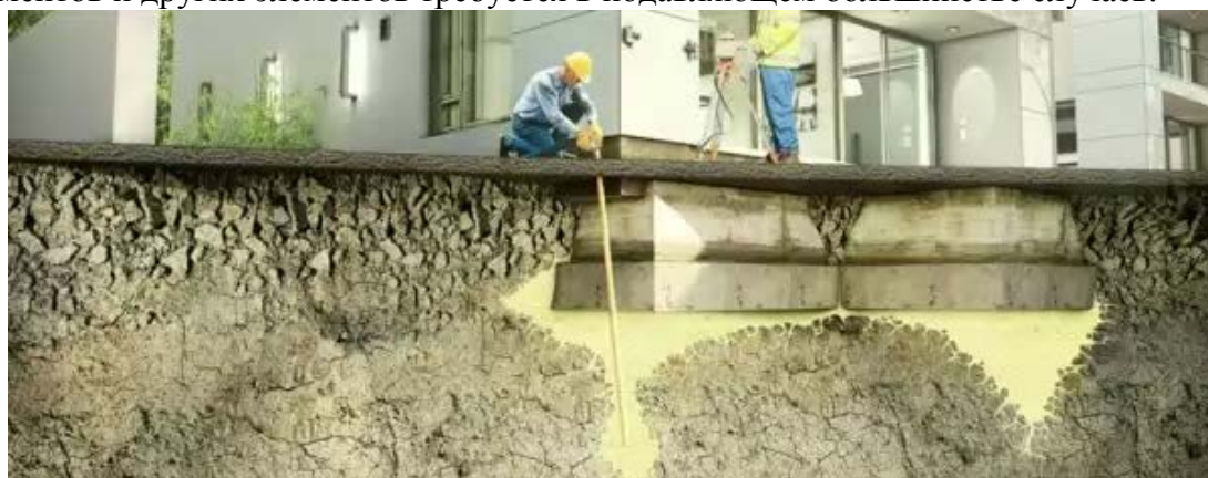
Упрочнение оснований под фундаментом
