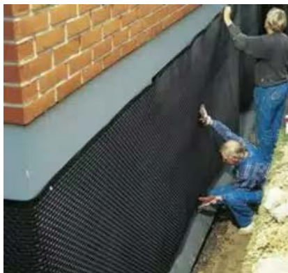
Подготовка к усилению фундамента
