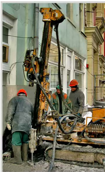
Упрочнение грунтов буроинъекционным способом
