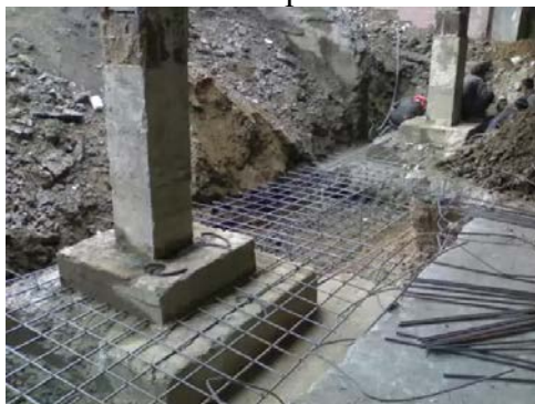
Упрочнение фундаментов столбчатых
